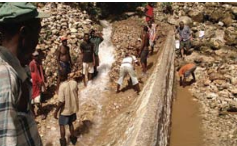
Dans le cadre de projets de coopération, réhabilitation du seuil déversoir à la centrale de Gaillard, en Haïti
