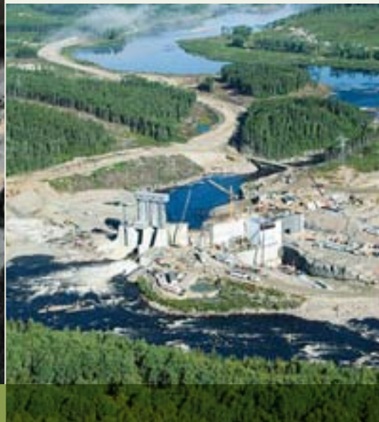
Chantier des Rapides-des-Cœurs
