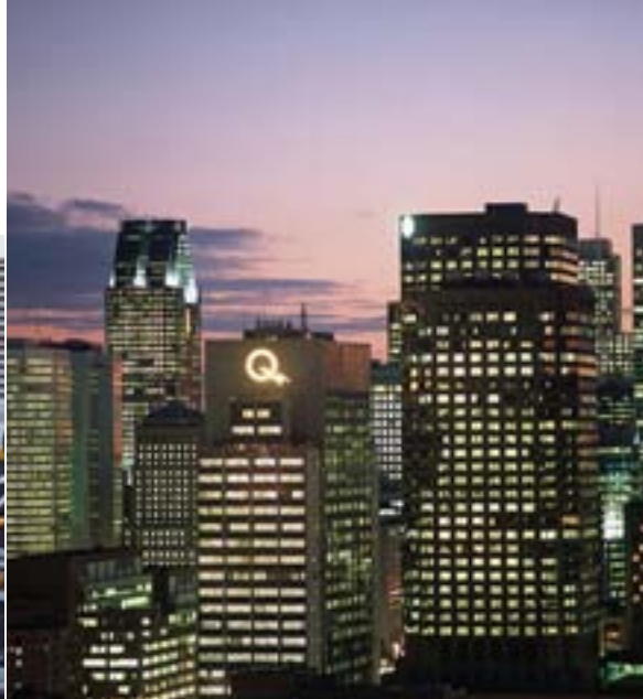
L'enseigne qui coiffe le siège social a pris les couleurs de l'efficacité énergétique. Un nouveau mécanisme pour régler l'ouverture et des lampes T-8 vont générer des économies annuelles de 43 000 kWh.
