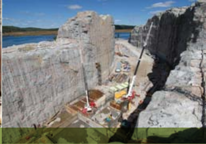
Chantier de l'Eastmain-1-A-Sarcelle-Rupert
